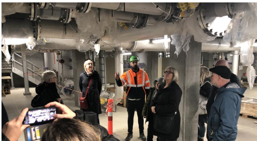
Værket ved Thorsbro er i gang med den store tur
