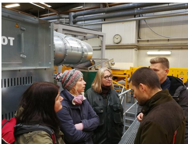
Besøg på plastsorteringsanlægget
