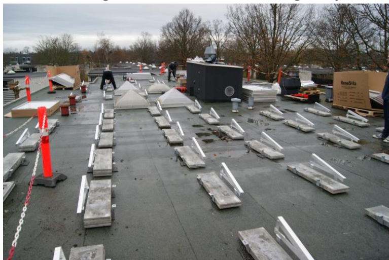
Solcellerne monteres på beboerhuset i VA 4 Syd
