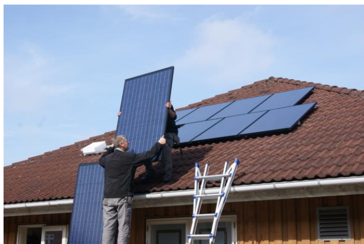
Solcellerne i Solhusene monteres
