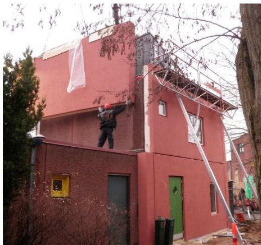
Et nyt isolerende vægelement sættes på det CO 2 -neutrale hus i Hyldebjergvej
