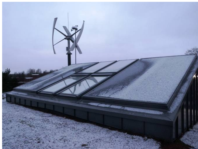
Solprismet og vindmøllen på det CO 2 -neutrale hus i Høkerlængen 2
