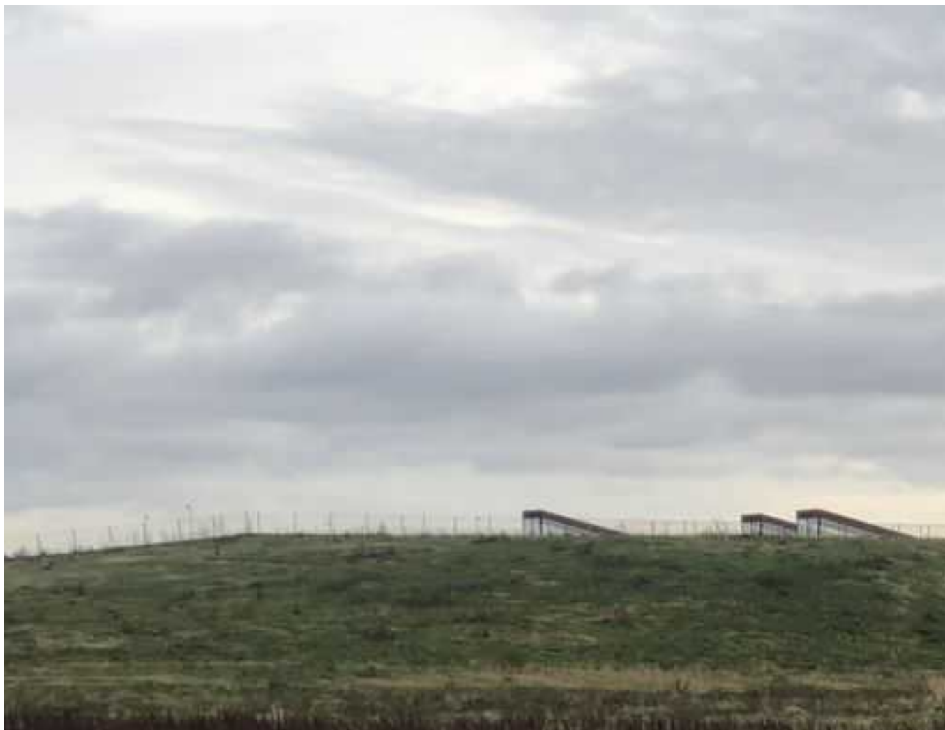
Det nye rensningsanlæg i Hillerød er helt overdækket
