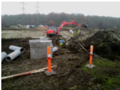
De nye våde enge anlægges
